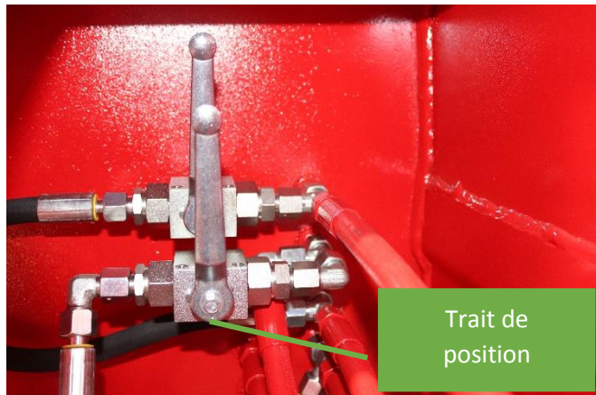
Figure 6 Vannes en position fermée
