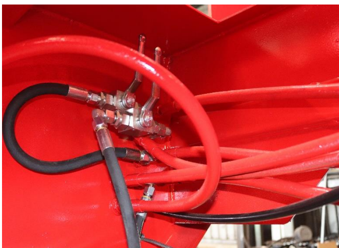
Figure 4 Vanne de commande de la BAE, derrière la face avant
